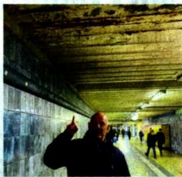
„Keine Visitenkarte“: Thomas Nüchel im Tunnel zu den Bahnsteigen.
